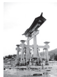
根継ぎ工事の写真
