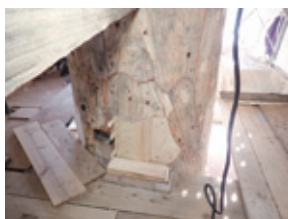
伝統的な工法(埋木) 柱の傷んだ部分を取り除き、他の木材で埋めている。
