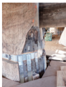
現代的な工法 スーパーステンレスの輪によって補強された主柱の内部の様子。
