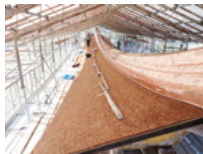
檜皮葺。張り替えられた赤褐色の銅板は美しく輝いていた。
