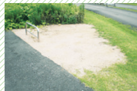
施工後1年を経過
