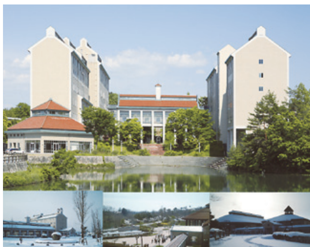
広島県立大学(平成元年4月~平成17年3月)
